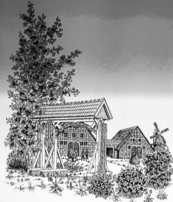
Die Twielenflether Pforte am Deich 31 in der Ersten Meile hat einen Kopfholtzstichbogen und ein Satteldach.
